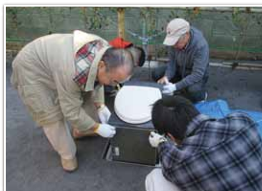
地下収納トイレの組立訓練
