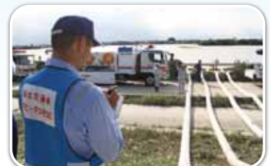
常総市で鬼怒川における排水ポンプ車の稼働管理
