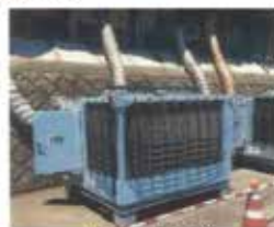
エアコン(室外機)
