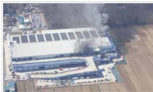
火災時の建物の状況（埼玉県防災航空隊提供）
