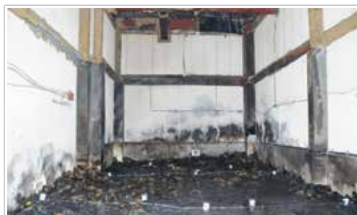
1階端材室内部の状態
