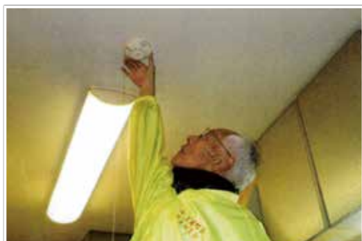
おたすけ隊による火災警報器の設置
