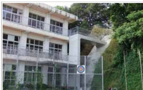
3階のベランダから高台への階段がついた黒潮町立伊田小学校
