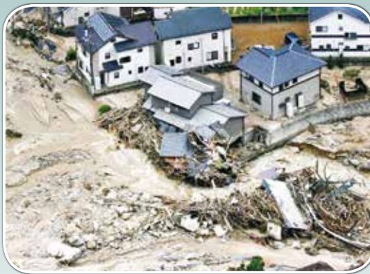
広島県安芸郡坂町
