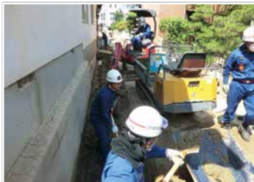
消防団活動（水路の土砂撤去）
