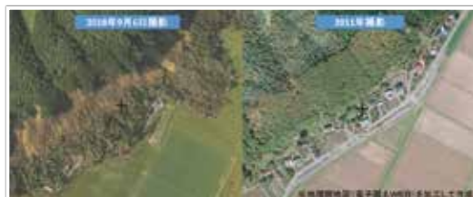
被害の状況(厚真町 吉野地区)
