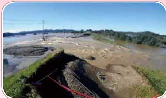
那珂川の堤防が決壊した茨城県城里町
