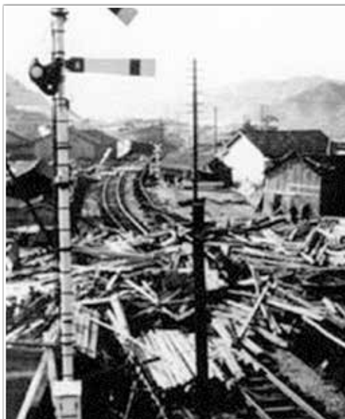
線路を津波による漂流物がふさぐ須崎市浜町付近 (提供 須崎市) (高知県庁ホームページ)
