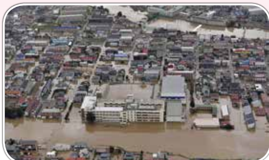
阿武隈川が氾濫した福島県郡山市
