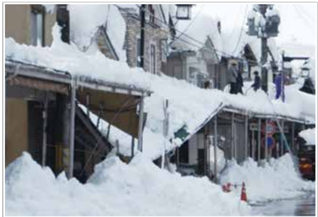
写真4 新潟県長岡市与板地区でのアーケードの倒壊
