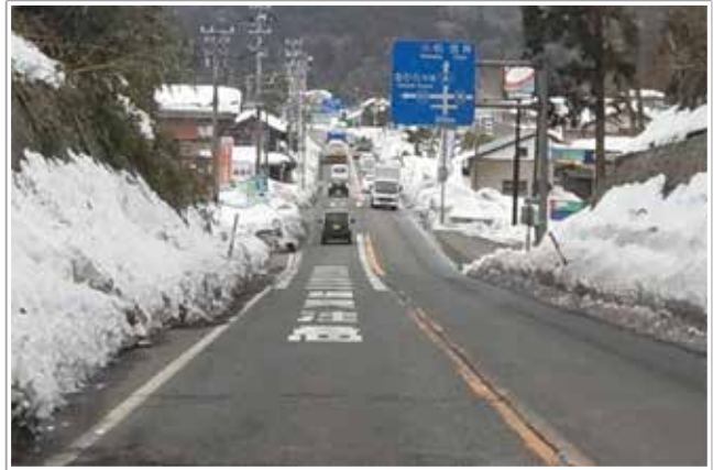
写真3 福井県あわら市内の国道8号 (2月16日大雪時には車が立往生していた所)
