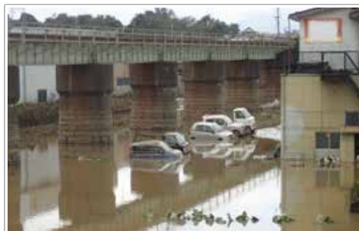
写真4 福島県郡山市の浸水被害
