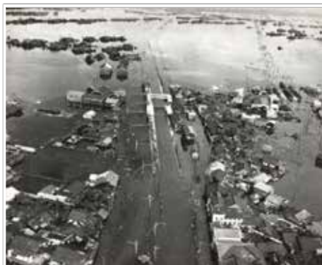
冠水した弥富駅周辺
