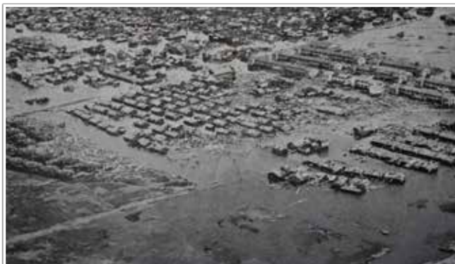
高潮と流木で死者660人を出した名古屋市南区白水住宅一帯 (『伊勢湾台風災害誌』より)
