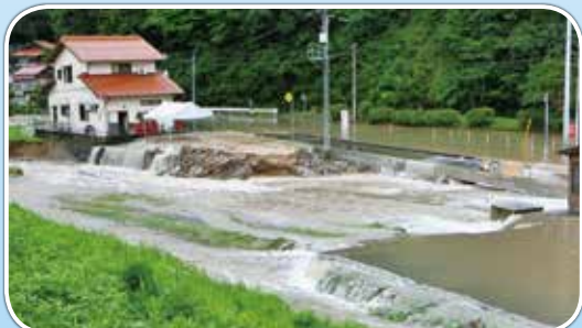
江の川が決壊し住宅地に浸水（島根県江津市）
