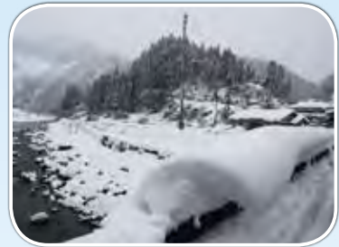
兵庫県香美町長須橋の欄干
