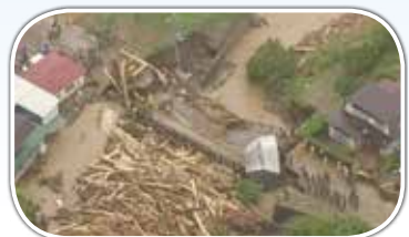
大雨で道路が寸断した青森県むつ市
