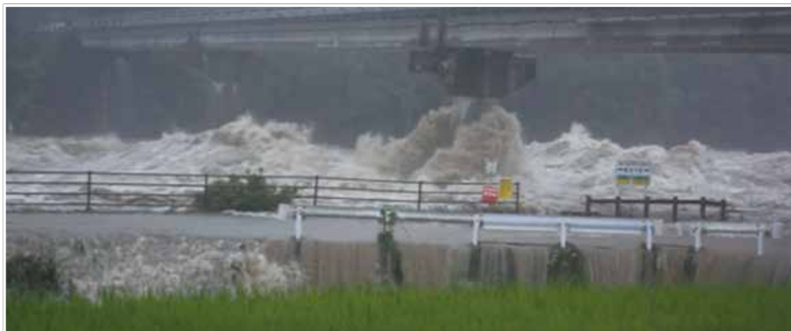
野村ダムの緊急放流により、濁流が堤防を越水する瞬間
