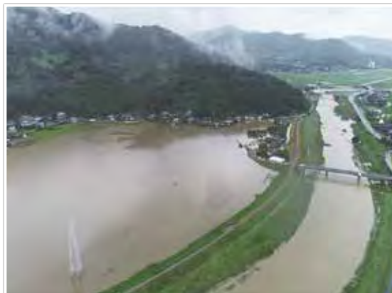
河川氾濫による被害区域確認の様子
