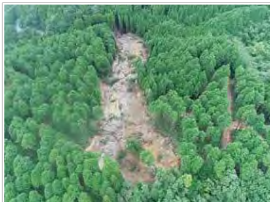
大雨による地すべり発生箇所の様子
