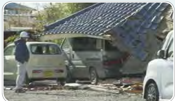
福島県国見町藤田地区の木造2階建て住宅
