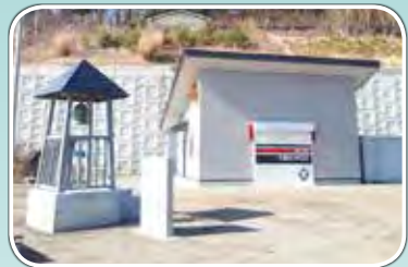
完成した岩手県大槌町消防団第2分団の防災倉庫兼津波待避所
