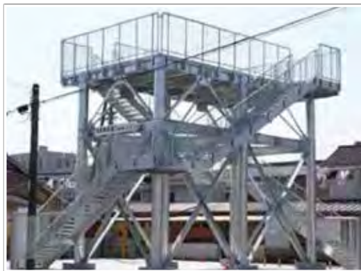
写真2 津波避難タワーの設置
