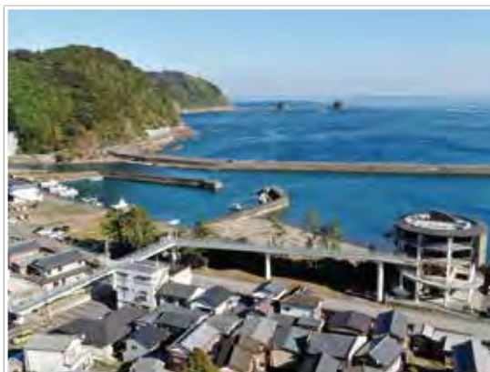
第1号津波避難タワー
