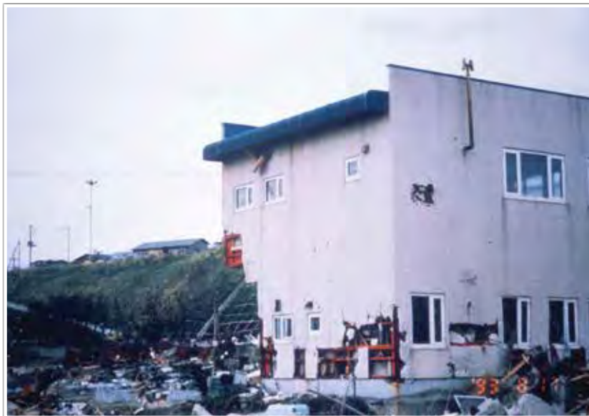
津波に洗われた建物2階の軒下に木片が挟まっている。 少なくともこの高さまで津波が来た。
