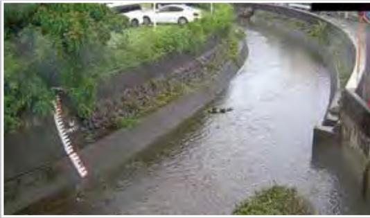
写真2 支流大堀川の水位確認板
