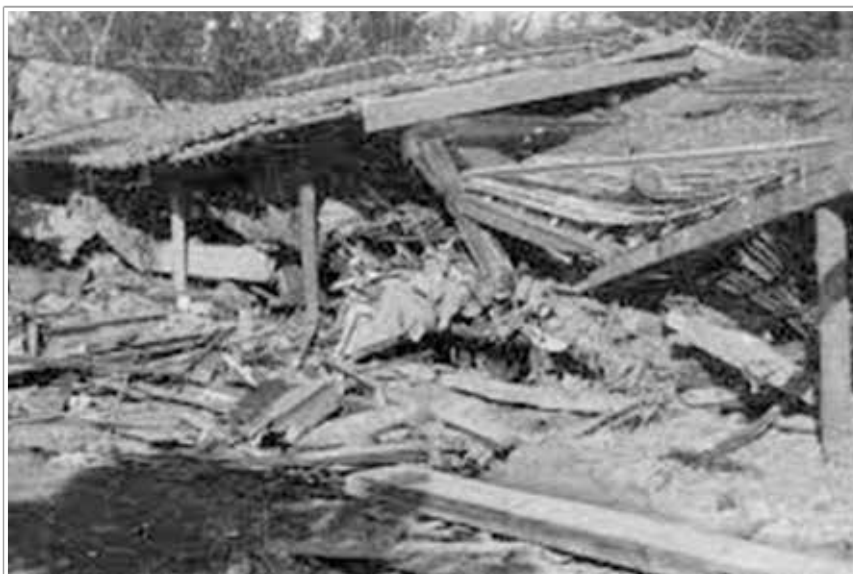
三河地震で倒壊した家屋（愛知県西尾市）
