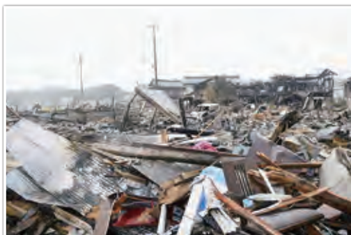
石川県能登町の被害状況
