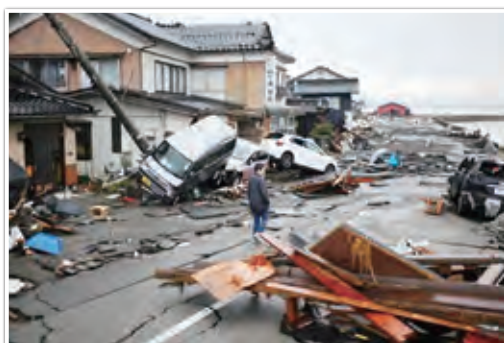
石川県珠洲市の被害状況
