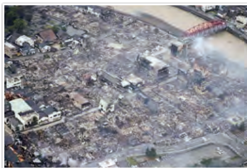
石川県輪島市の被害状況
