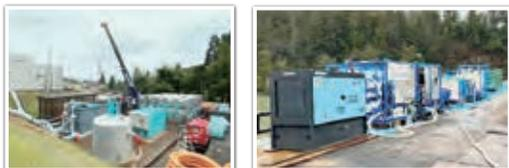
図8 可搬式浄水設備設置事例
