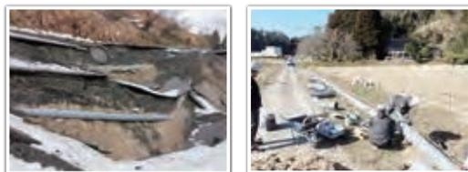
図1 上下水道システムの急所となる施設の被害状況(左:送水管、右:処理場に直結する圧送管)
