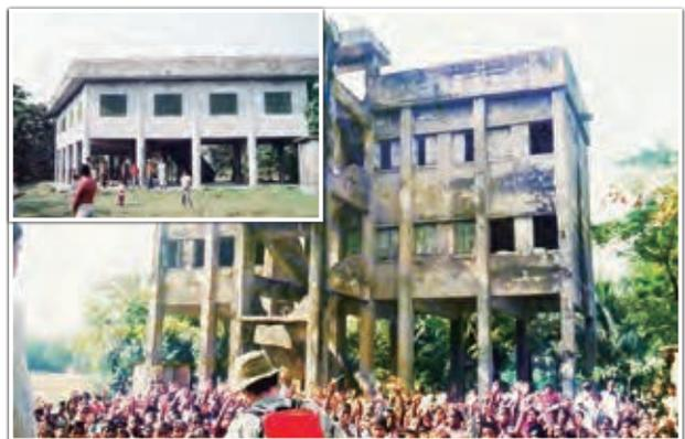
写真1 バングラデシュのサイクロンシェルター（1991年当時、小学校として利用されていた例が多い。コンクリートが劣悪なため、風化が激しい）。左上は最近のアロータイプのシェルター
