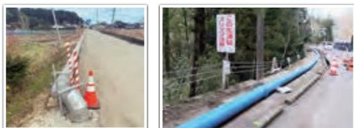
図7 仮設配管（転がし配管の活用事例）
