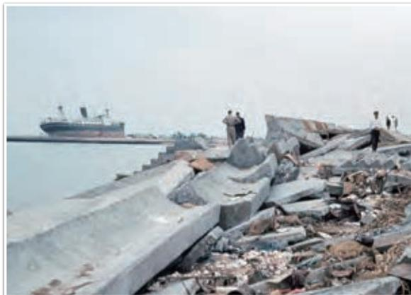
写真2 1959年伊勢湾台風による高潮と高波による護岸の決壊と大型貨物船の漂流（わが国で初めての被災地のカラー写真）
