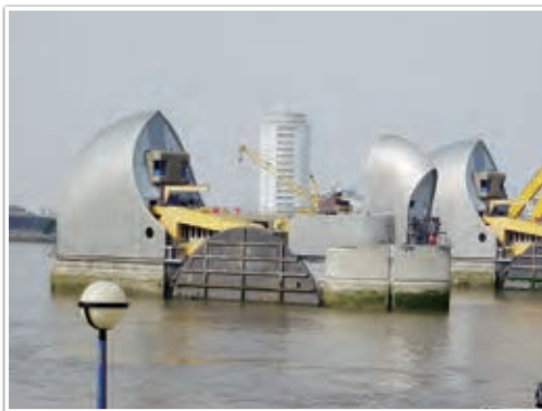
写真3 テムズ川に設けられた回転型高潮水門でロンドンを守っている。
