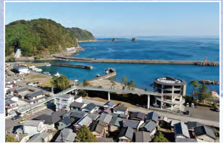
第1号津波避難タワー
