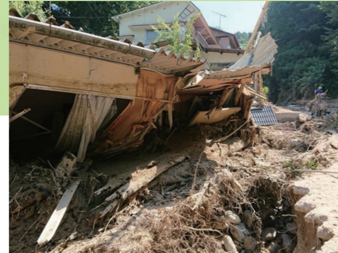
平成 30 年 7 月西日本豪雨での被災写真
