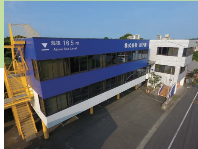
屋上へ避難できる外部階段を設置し、標高を明記した自社ビル
